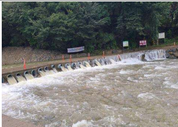
강우시 하천수의 교량 범람
