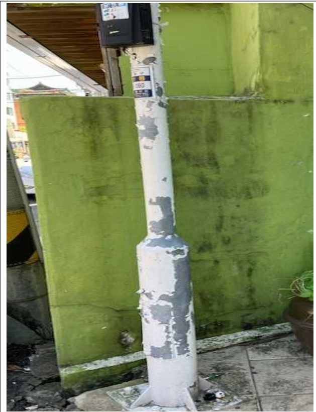
도색 보안등 불법광고물 부착방지판 설치
